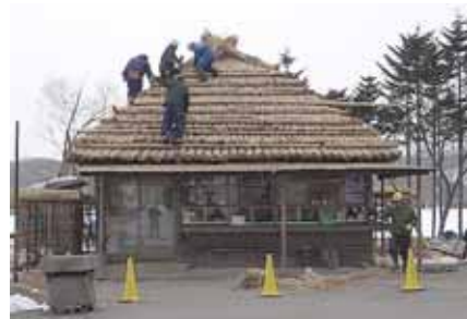
屋根の茅の葺き替え作業
